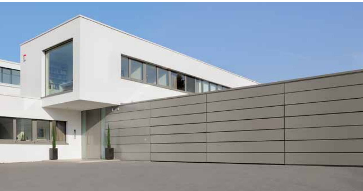
Поставяна на място обшивка с алуминиеви многослойни плочи
